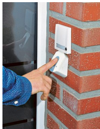
Den Finger über das Lesegerät ziehen, schon entriegelt sich die Eingangstür des Bürogebäudes.
